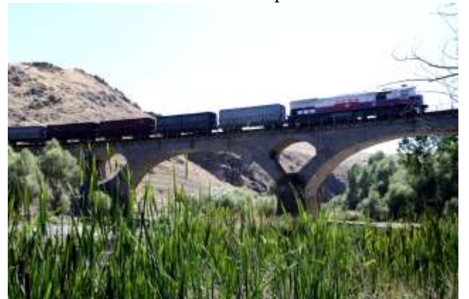
DDY Devrez Köprüsü
