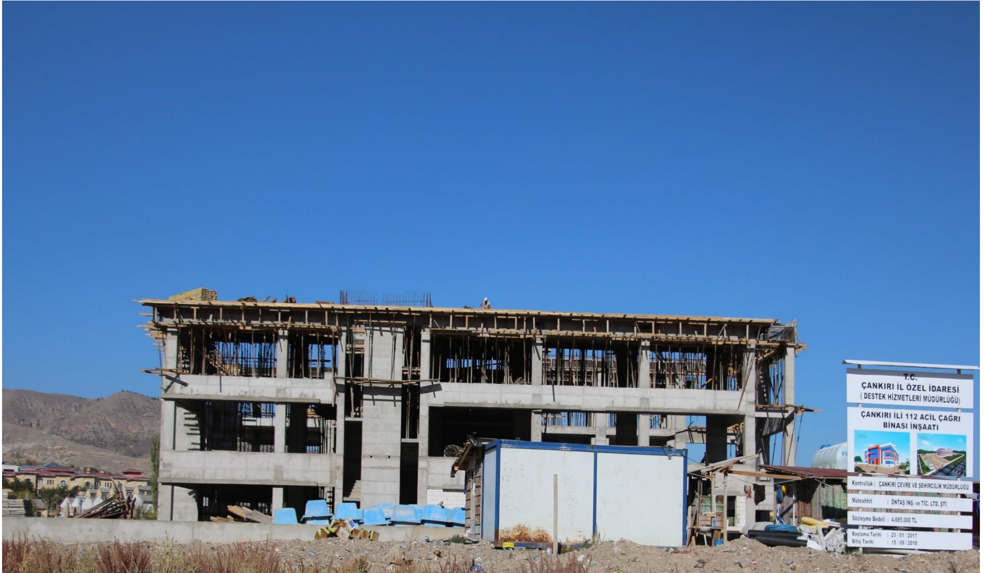
112 Çağrı Merkezi Binası İnşaatı
