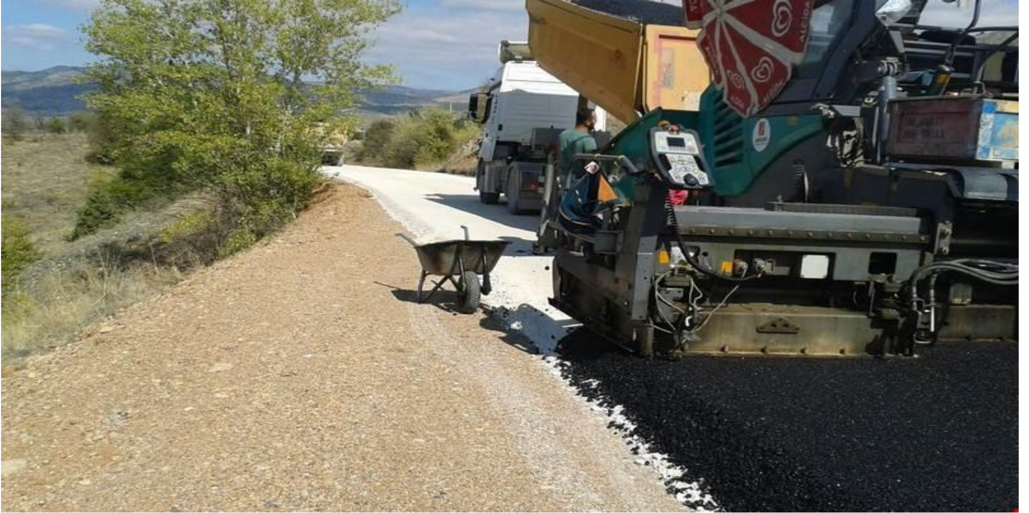
Alpsarı Grup Yolu Sıcak Asfalt Çalışması
