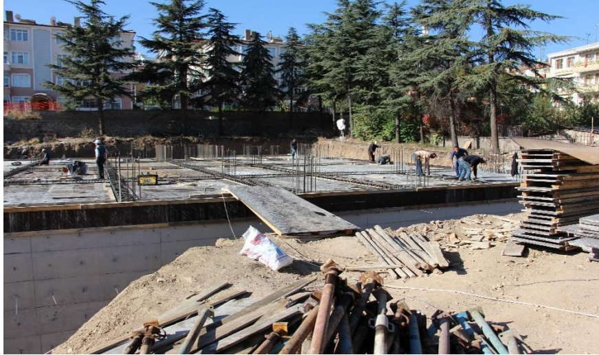
Abdulhalik Renda Mahallesi Ortaokulu İnşaatı
