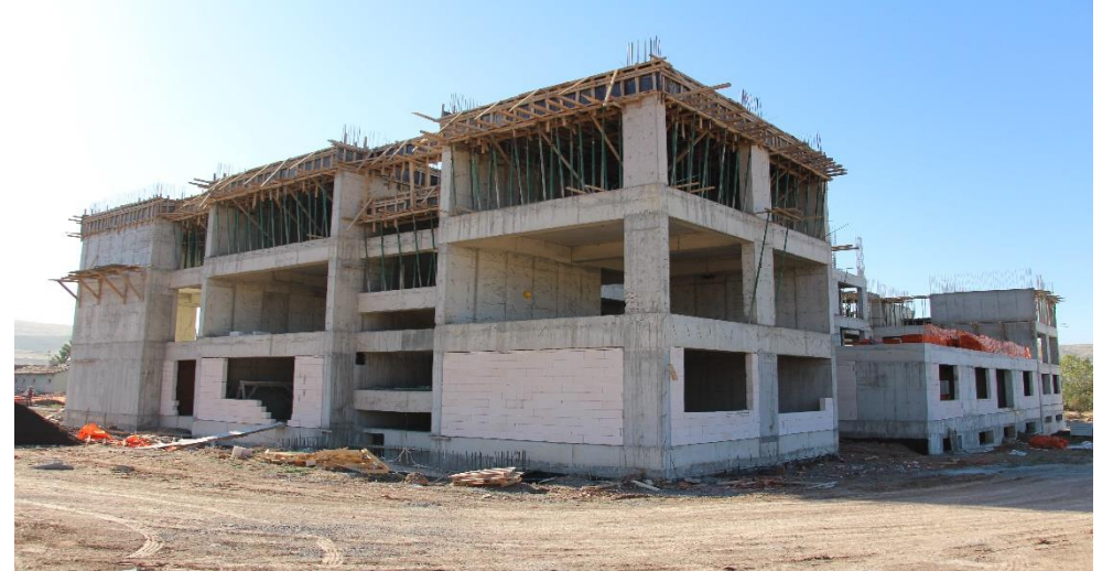
Merkez Tarım Meslek Lisesi İnşaatı
