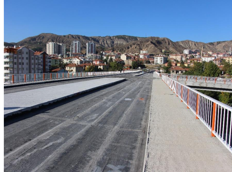
Merkez Aşıyan Sitesi Köprülü Kavşak İnşaatı
