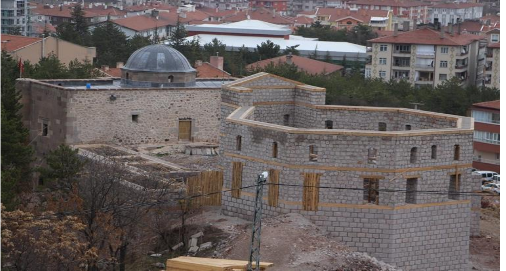
Taşmescit Semahane ve Mevliahane Restorasyonu
