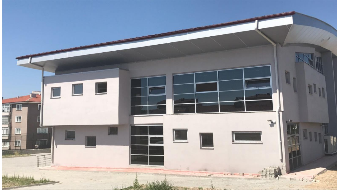
Çerkeş İlçesi Gençlik Merkezi ve Tenis Kortu
